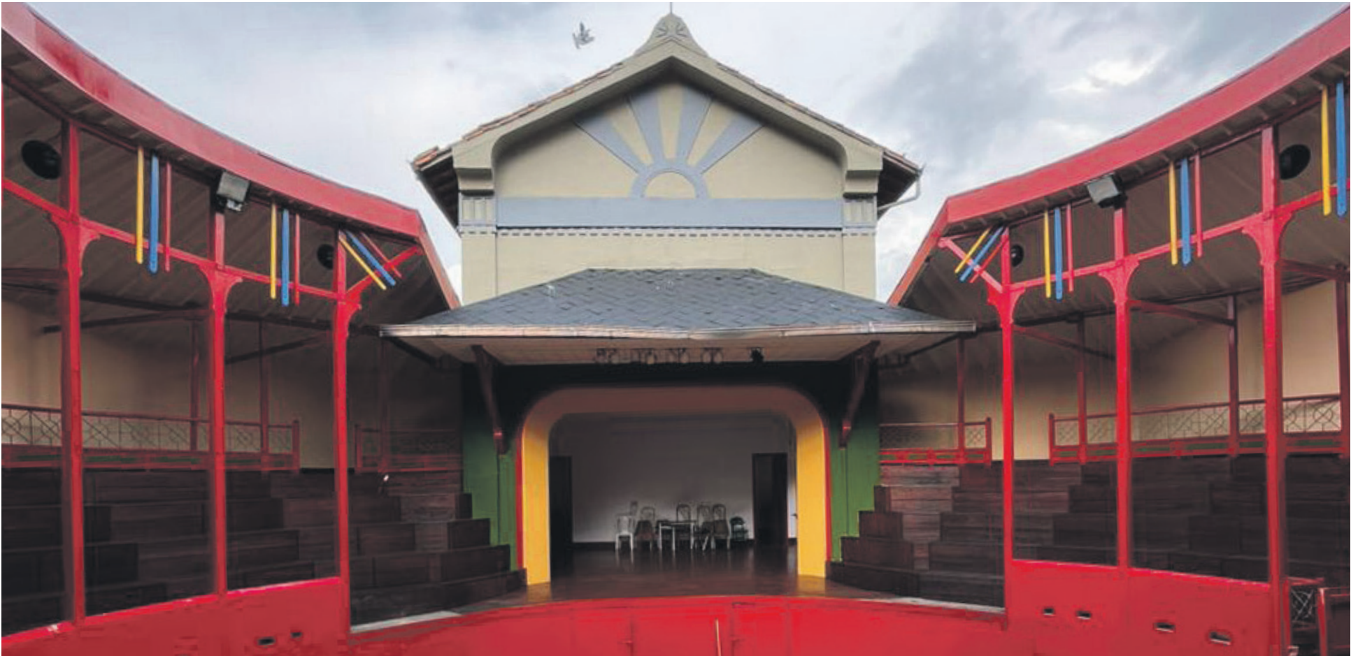
Intervención y mantenimiento del Circo Teatro Girardot por sus 100 de años de inauguración. Inversión: $86.066.640.
