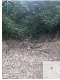
Deslizamiento material tipo detrito Quebrada Los Chorros parte alta
