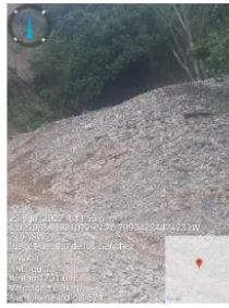
Deslizamiento material tipo detrito Quebrada Otília 2 parte alta
