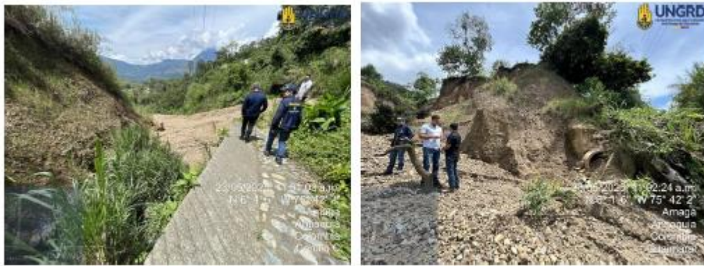
FIGURA 8. TRAMO DE VÍA DEL CORREGIMIENTO CAMILO C QUE CONDUCE HACIA LA VEREDA GUAIMARAL
