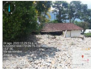
Predio Las Tortugas parte baja de la OC86 en el K25+900 de la UF2 Tramo 12
