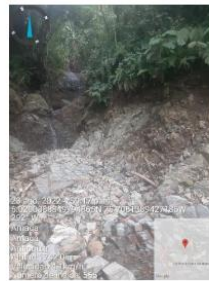
Deslizamiento material tipo detrito Quebrada Otília 1 parte alta
