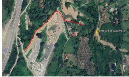
FIGURA 3. APORTE CAUDALES PROVENIENTES DEL TUNEL VIA NACIONAL PACIFICO 1. Fuente: Comunicación Alcaldía municipal Amaga, 2024.
