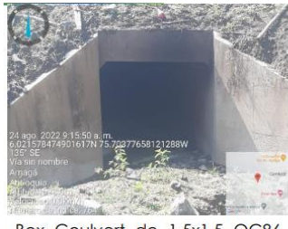
Box Couvert de 1.5x1.5 OC86 en el K25+900 UF2 Tramo 12
